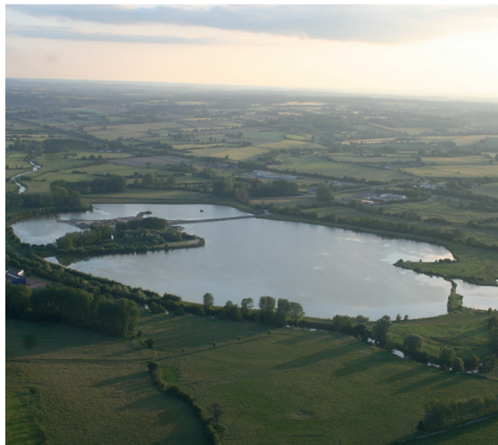
Le plan d'eau des Ajeux avant les aménagements
