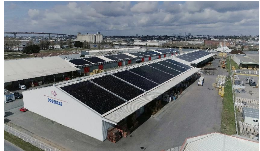
Figure 12 : centrale photovoltaïque en toiture de Cheviré
