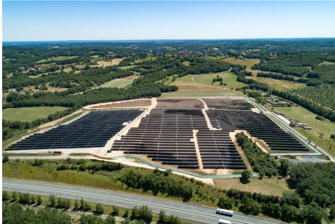
Figure 14 : vue aérienne de la centrale photovoltaïque de Thenon (24) exploitée par JPee
