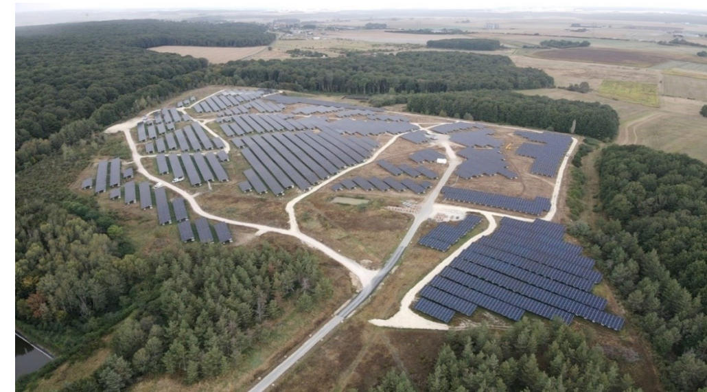
Figure 16 : Vue de l'ancienne décharge d'Orchaie (41) exploitée par Suez Grand-Ouest, sur laquelle JPee exploite une centrale photovoltaïque de 8,4 MWc
