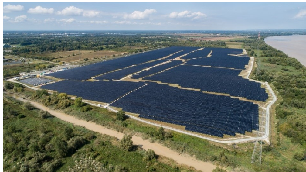
Figure 15 : Vue de l'ancienne décharge de Labarde à Bordeaux (33 - Parc de 59 MWc)
