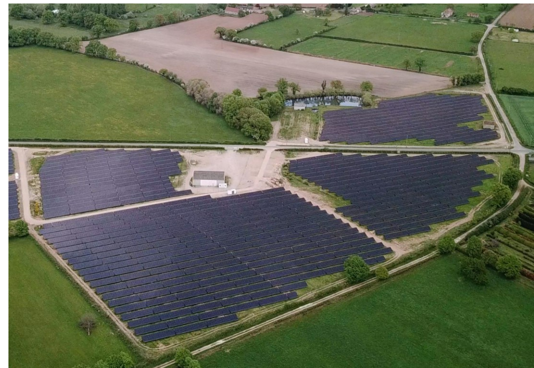
Figure 13 : vue aérienne de la centrale photovoltaïque de Braize (03) exploitée par JPee
