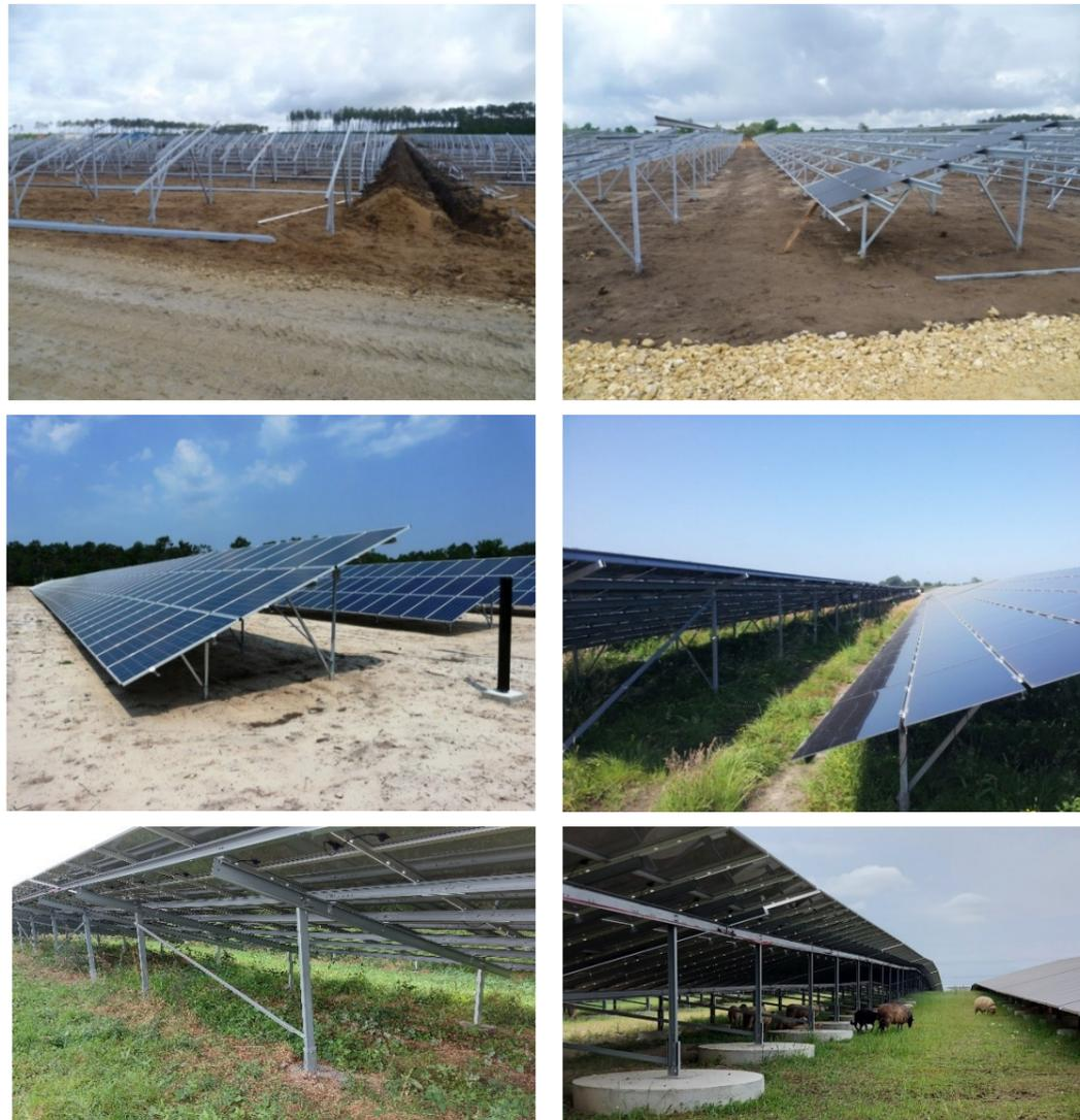
Photo 69 : Exemples de structures porteuses
