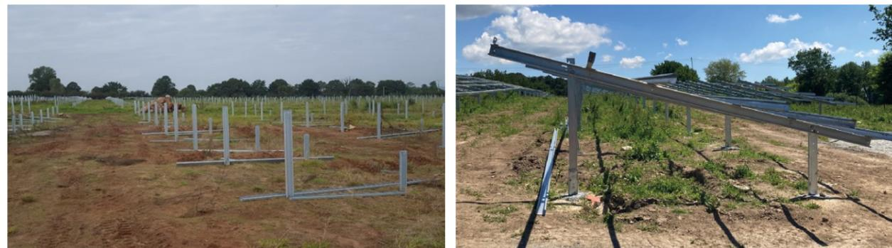
Photo 73 : Implantation de pieux battus (à gauche), montage avec des pieux préforés (à droite) et sur des longrines (ci-après)
