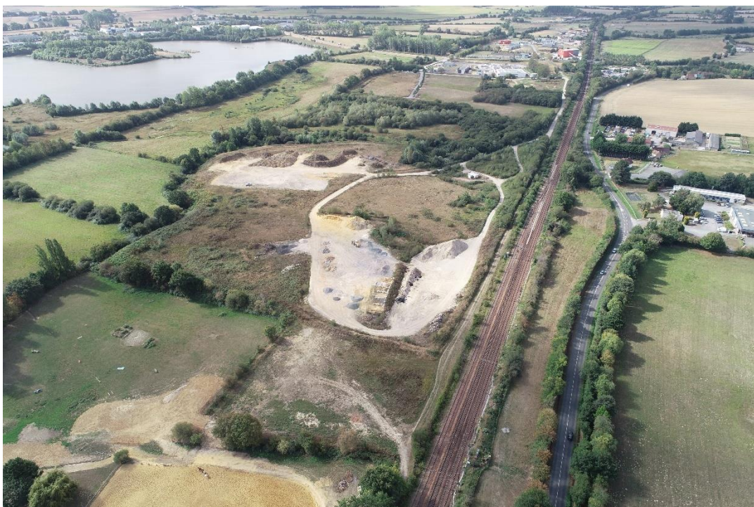
Vue aérienne du secteur et de la parcelle ZC 169, en août 2020 (par drone) Le site d'implantation de la centrale photovoltaïque et son emprise ouverte, délimités par les haies bocagères périphériques.
