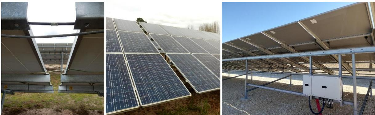
*Chemins de câbles électriques hors sol, sur les structures et sous les panneaux*
