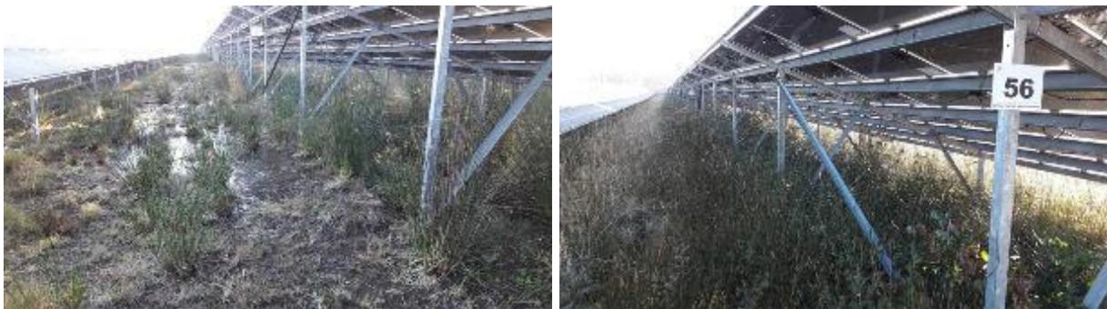
*L'utilisation de panneaux disjoints, placés à une distance suffisante du sol, permet une diffusion de la lumière naturelle sous les rangées et assure le développement des espèces végétales, également alimentées en précipitation.*
