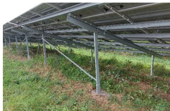
Photo 1 : Fondations possibles en longrines ou en micropieux préforés scellés au béton
