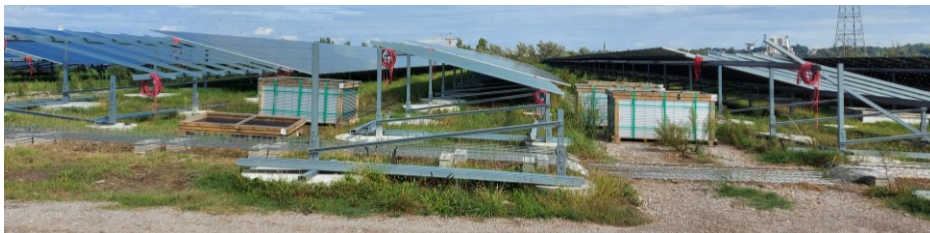
Photo 3 : Illustration de fondations superficielles par plots circulaires lors de la construction de la centrale photovoltaïque de Labarde (33).
