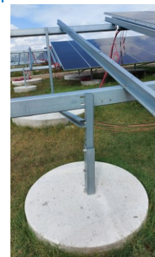
Photo 3 : Illustration de fondations superficielles par plots circulaires lors de la construction de la centrale photovoltaïque de Labarde (33).
