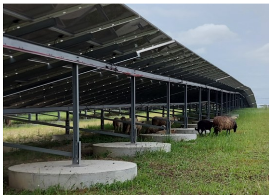
Photo 1 : Fondations possibles en longrines ou en micropieux préforés scellés au béton
