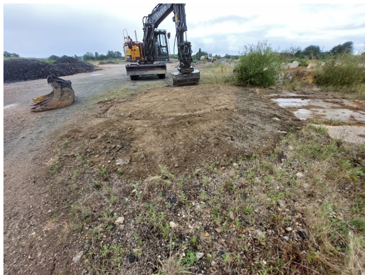
Photo 7 : Fouilles réalisées sur place à la pelle mécanique, fin juillet 2023
